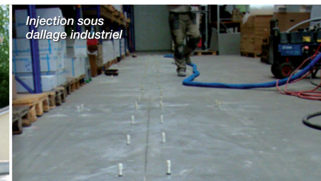
Comblement d'une cavité avec de la mousse de polyuréthane
