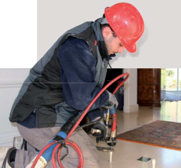
Traitement d'un défaut de portance dû aux déplacements des aéronefs (Aéroport Toussus le Noble, 78)
